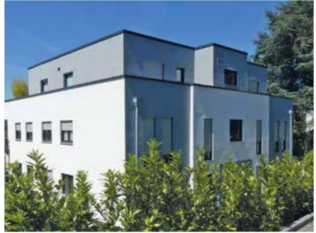
Ein Flachdach muss besonders gründlich abgedichtet und ständig über Dachabläufe entwässert werden, hat aber zwei große Vorteile, wenn die Bewohner eines Hauses mit Flachdach ihr Flachdach als Terrasse oder sogar kompletten Dachgarten nutzen.
